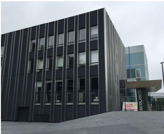
Université du Tertre, pendant les travaux
